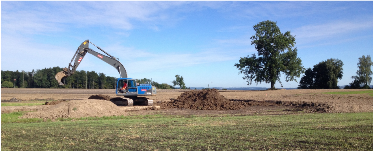
Bodenauftrag Etappe 1 (Bild: FRIEDLIPARTNER AG)
