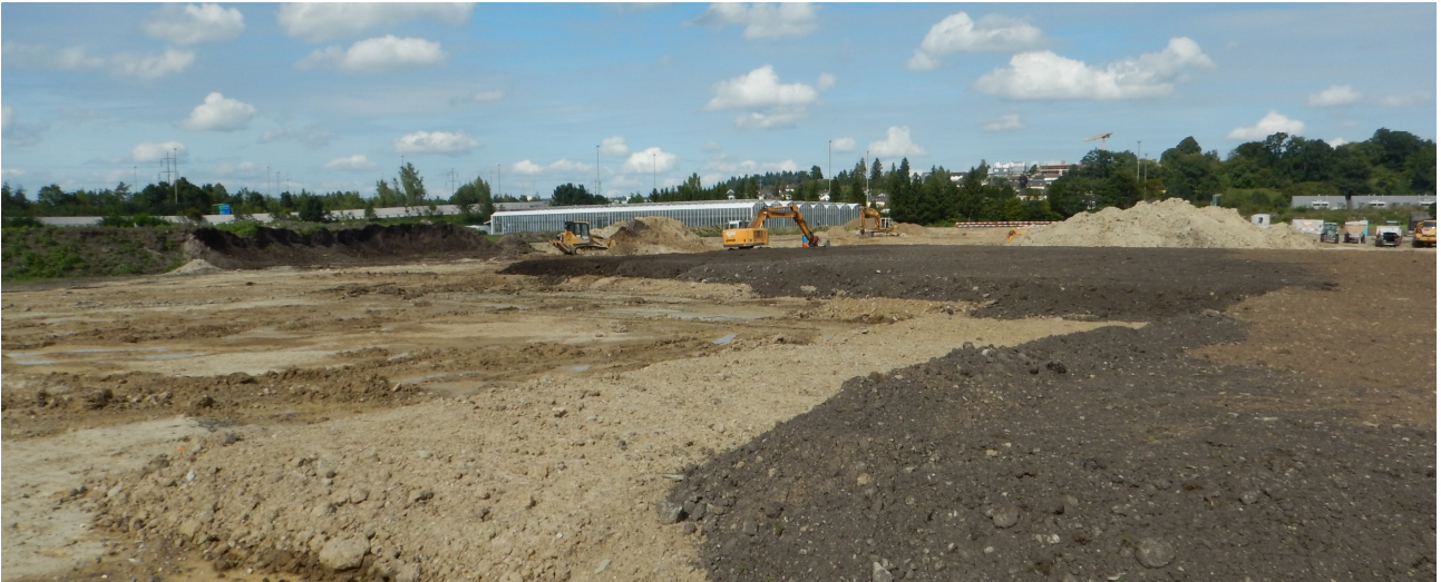
Bodenauftrag Kompensationsfläche (Quelle: FRIEDLIPARTNER AG)
