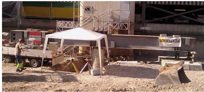
Pfählung Parkhaus P6 Kloten / stat. Zugversuch / 2011
