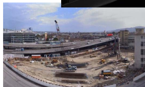
Pfählung Prime Tower / 2008
