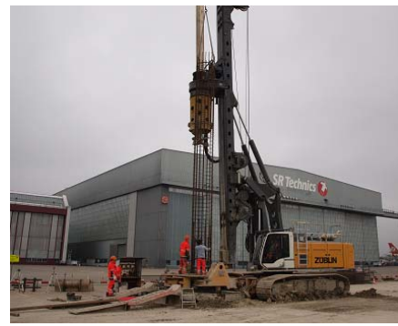
Flughafen ZH / LB 36 / Bohrtiefe 44m / 2012
