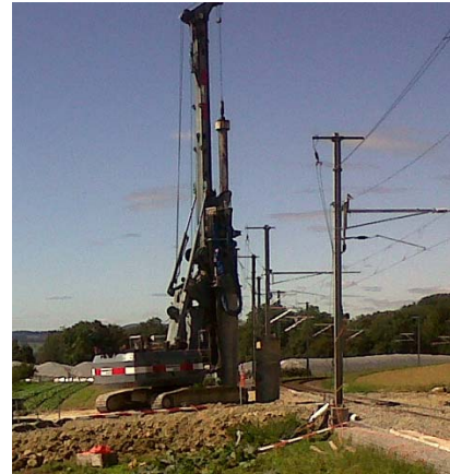
Pfählwand Unterführung Berg TG / 2012
