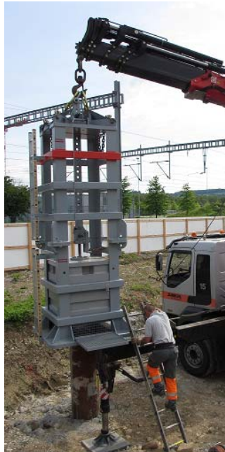
Schlieren Zürcherstrasse / Pfählung / Dyn. Druckprüfung / 2012
