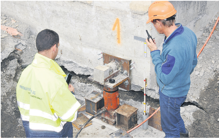
Eine der 18 Hydraulikpressen, mit denen das Haus zurechtgerückt worden ist.
