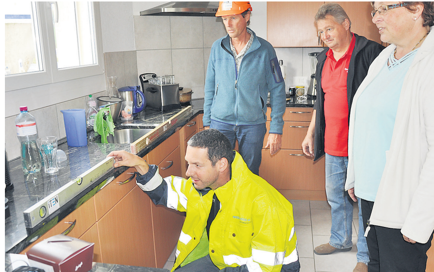
Die Kontrolle zeigt, dass Küchenablage und Herd nun wieder waagrecht sind. Fotos: Fredy Stäheli
